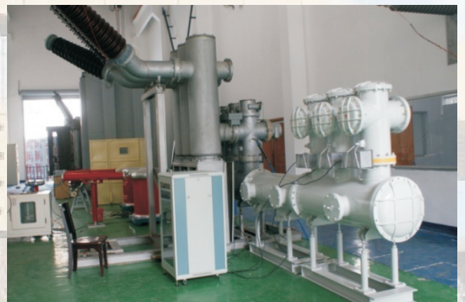
电气学院真型电力设备研究平台 (变压器与GIS)
