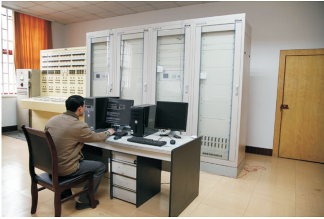
电气学院电力系统可靠性分析平台 (RTDS)
